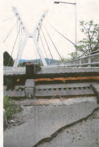
写真3 ■ 2径間連続鋼斜張橋の桑鶴大橋。1997年に竣工した。鋼製ジョイント部は大きな段差が発生(左)。防水性のシール材らしきものが溶けてずたずたに。鋼製支承は破損して桁が脱落していた(下)
