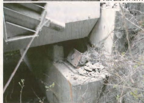
写真3 ■ 2径間連続鋼斜張橋の桑鶴大橋。1997年に竣工した。鋼製ジョイント部は大きな段差が発生(左)。防水性のシール材らしきものが溶けてずたずたに。鋼製支承は破損して桁が脱落していた(下)
