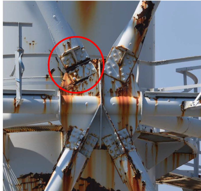
東側(GL+45m付近)
