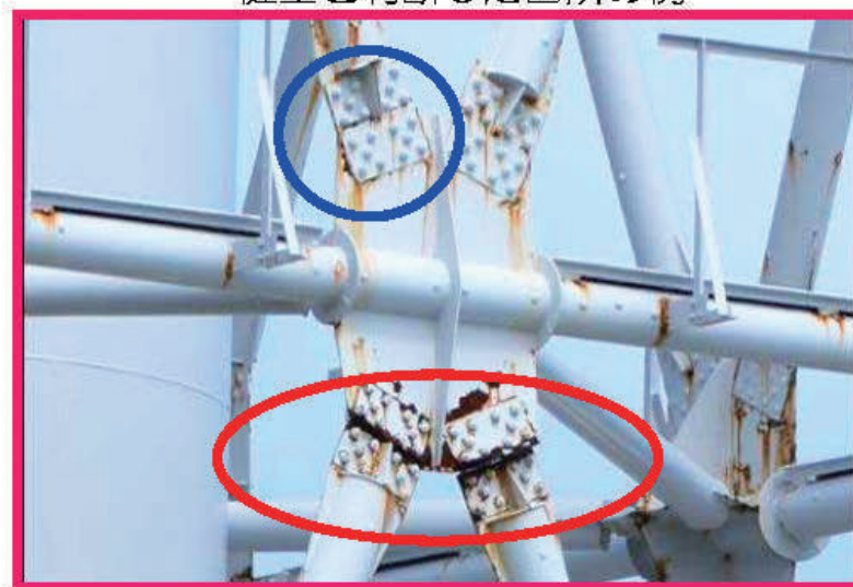
破断及び変形と判断した箇所の場合
